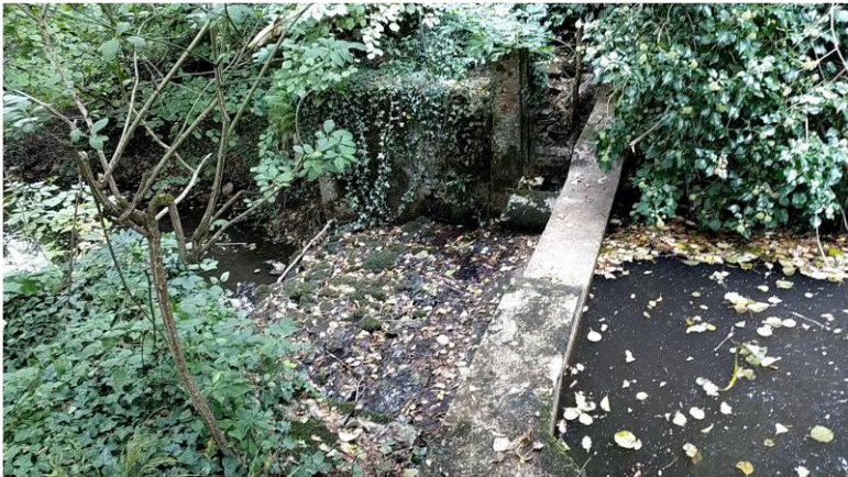
Déversoir de la retenue du moulin du Champ Renier
