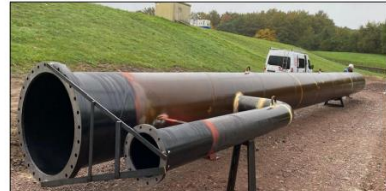
Prolongation de la conduite de vidange Ø1000
