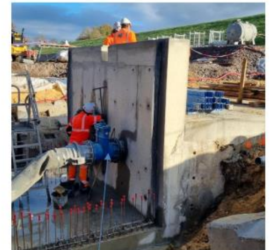
Vanne provisoire permettant d'assurer le soutien du Lathan
