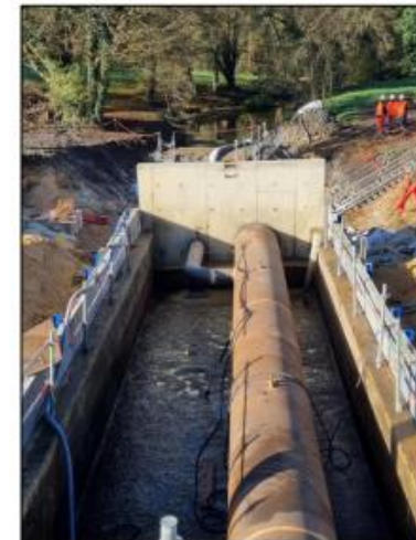
Pose de la conduite dans l'ancien canal de vidange
