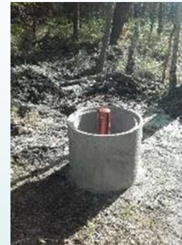
Pose de 3 piézomètres pour le suivi des nappes
