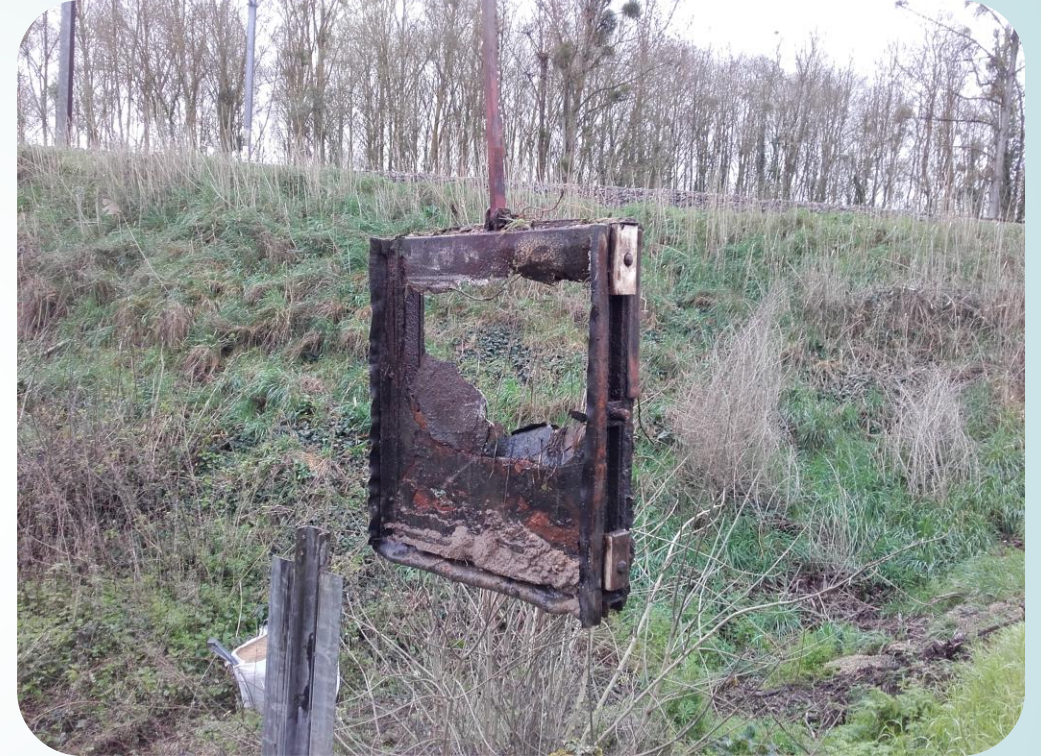
Vanne CE 5010 endommagée pendant une crue – mars 2020
