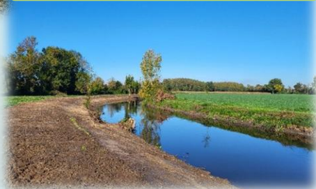
Dévasement et retalutage
