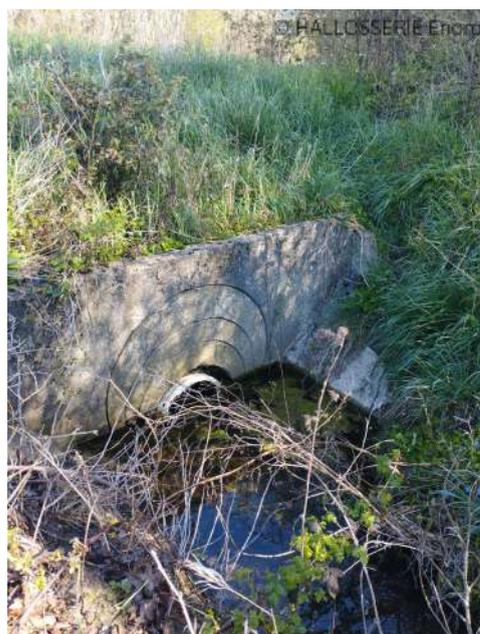
Figure 26: Buse installée trop profondément.
