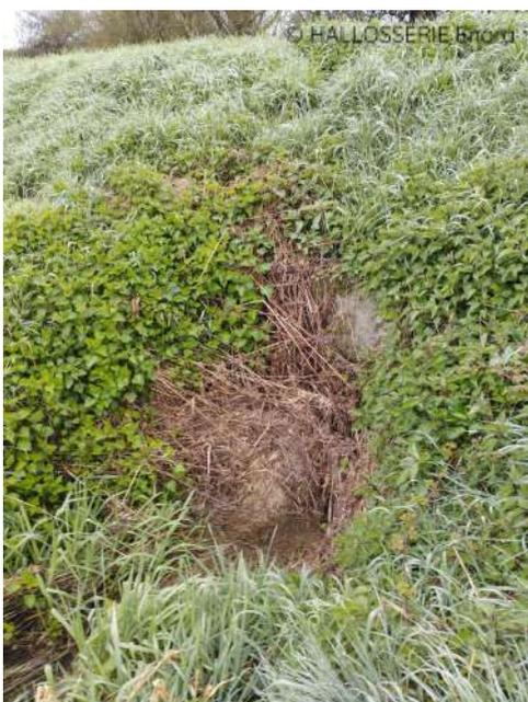
Figure 25: Buse encombrée par les débris de fauche.
