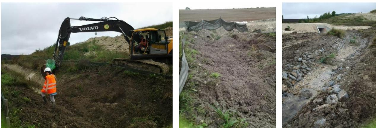
FIGURE 8 : PHOTOS D'UN EXEMPLE DE GRIFFAGE DE COURS D'EAU AVANT DESTRUCTION ET DE LA REUTILISATION DE LA VEGETATION SUR LE NOUVEAU TRACE – T HERCE
