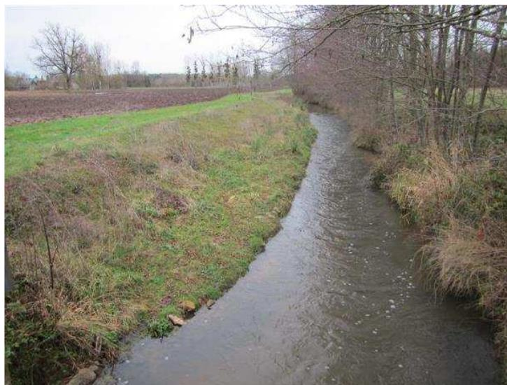
**Figure 4 : retalutage et banquette réalisée dans le cadre des travaux de restauration du Lathan en 2017**
