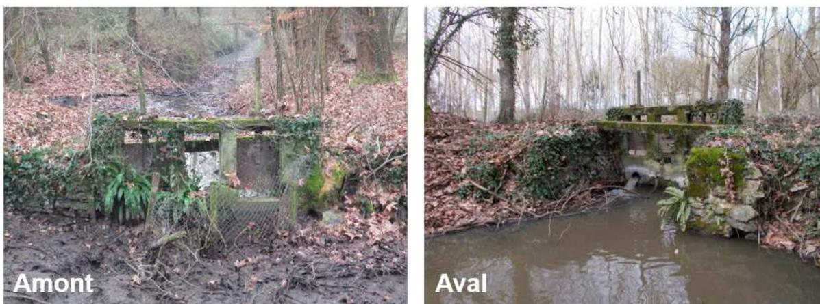
**Figure 19 : vue amont/aval de l'ouvrage existant de prise d'eau du bras du Perray**
