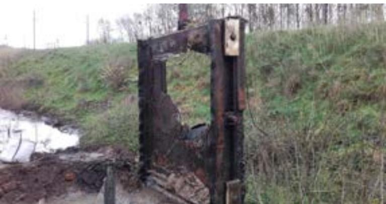
Suite à une crue, l'ouvrage vieillissant et inutilisé depuis de nombreuses années a cédé. L'eau en provenance de l'Authion, s'est engouffrée dans le canal 5010. Il a fallu endiguer la brèche et bloquer le passage pour éviter le retour d'eau en cas de nouvelles crues.
