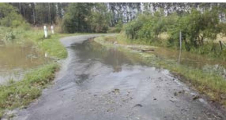
Certaines crues provoquent l'arrachage et/ou le transport de débris végétaux. Ceux-ci viennent ensuite se bloquer dans les passages busés, ce qui provoque une inondation.
