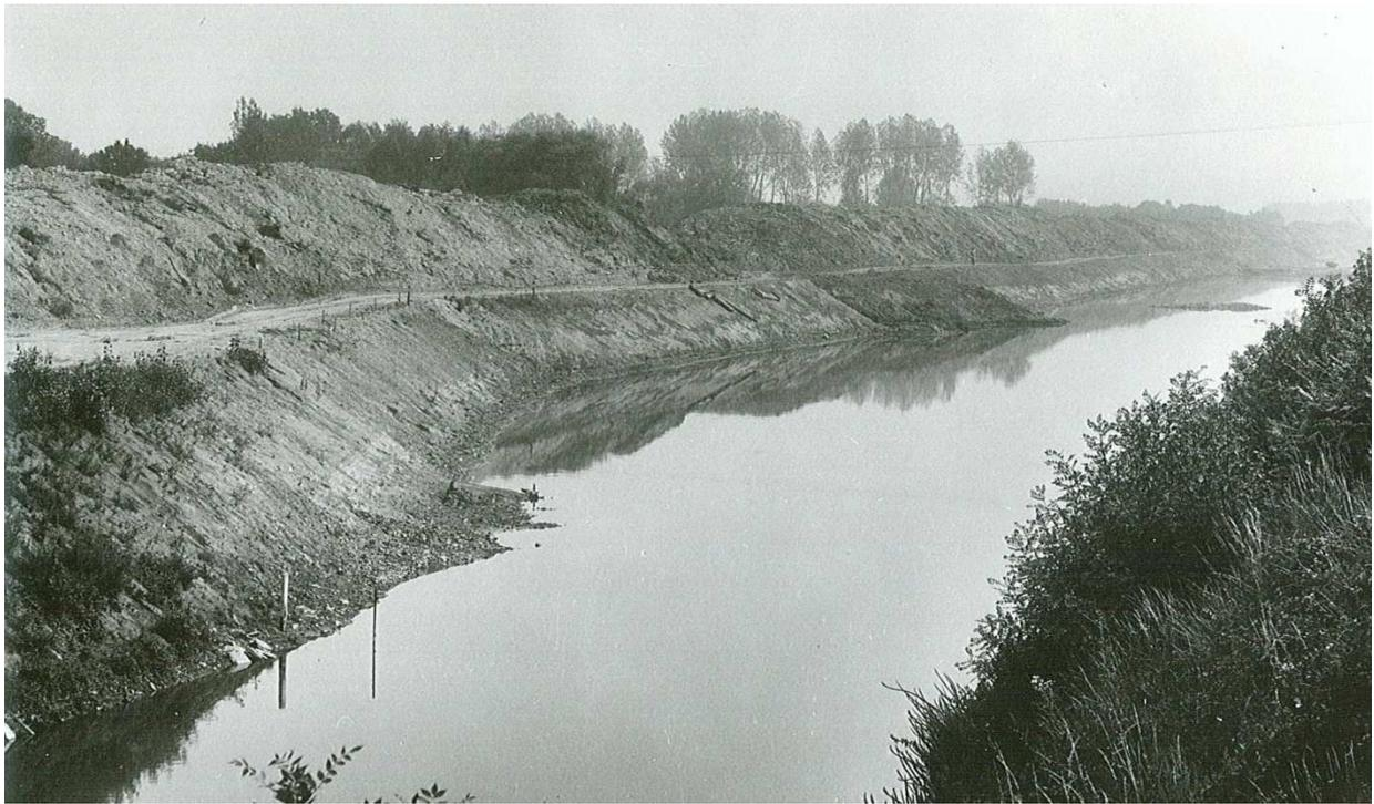
Figure 7 : Vue des travaux de recalibrage de l'Authion, vers 1960
