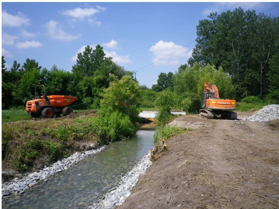
Figure a7 : Travaux de recharge granulométrique et abaissement de seuils sur le Couasnon
