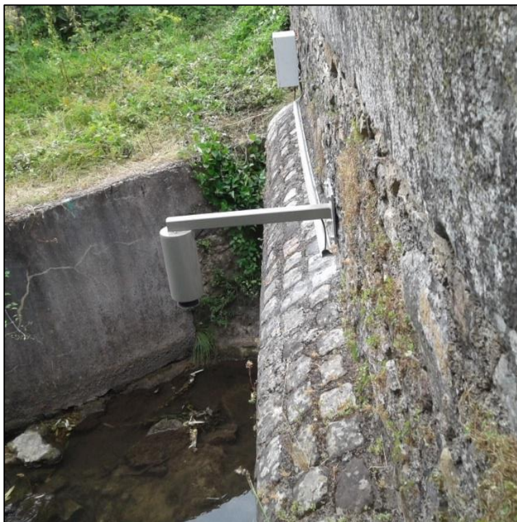
Vanne de décharge du moulin de Gée
