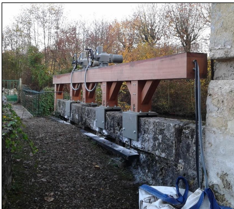
Vannes de décharge du moulin de Baugé (Baugé en Anjou)
