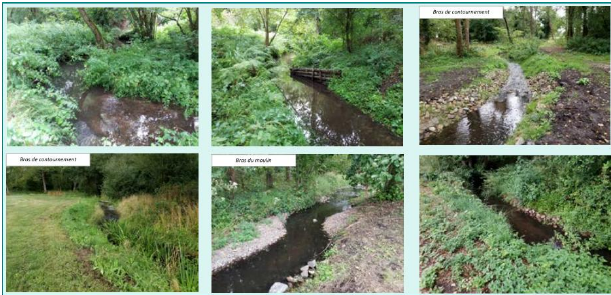
Figure 3. Travaux de restauration de la continuité écologique sur la Riverolle
