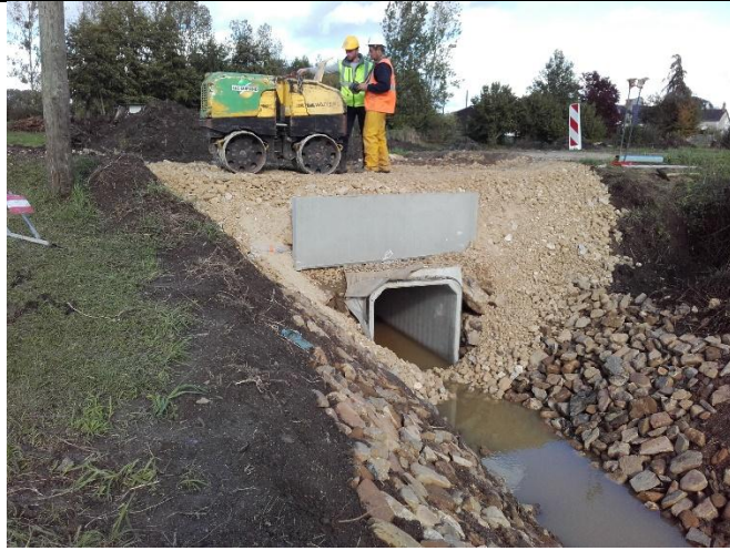
Aménagement du passage routier
