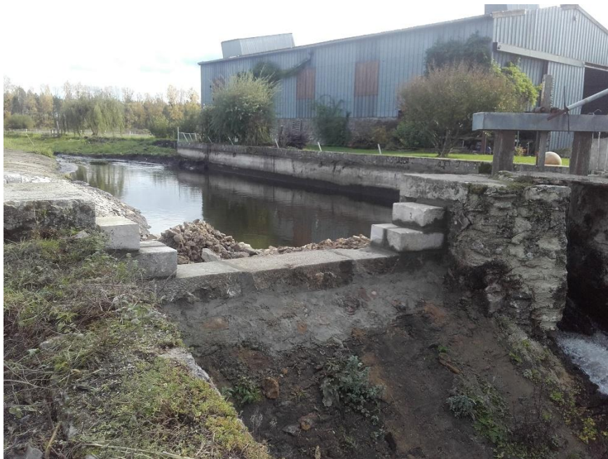
Abaissement du seuil du Moulin
