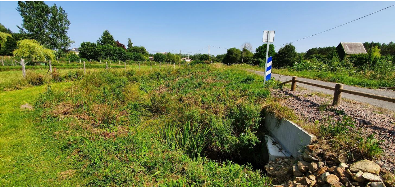
Sécurisation du passage routier
