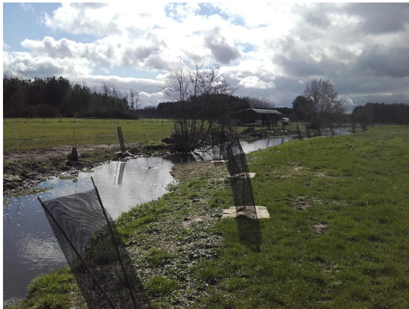
Travaux sur le bief du moulin
