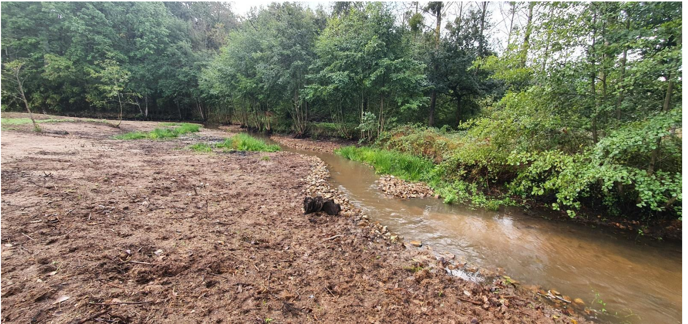
Reprise de berges et banquettes
