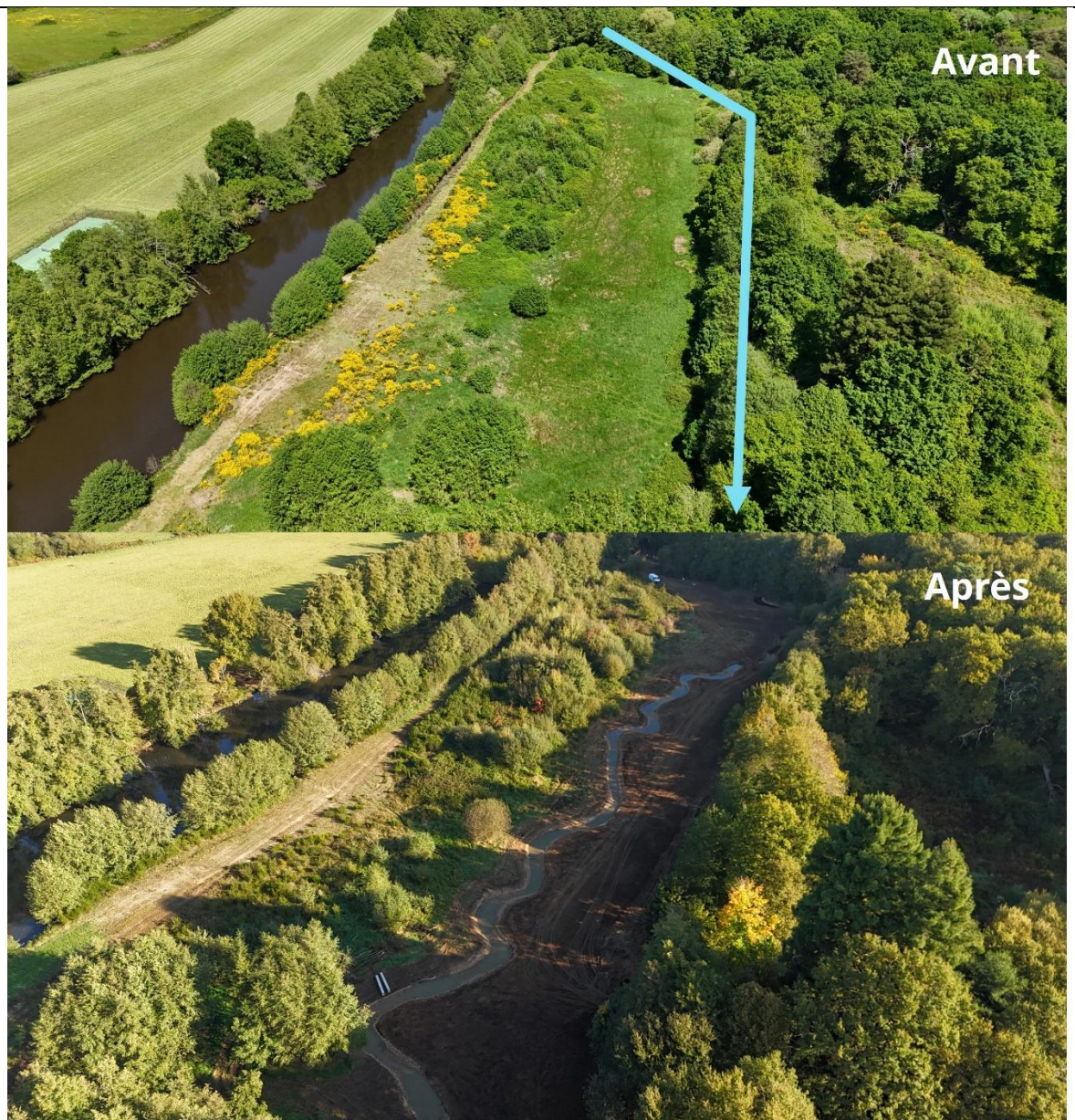
Photo aérienne avant et après travaux
