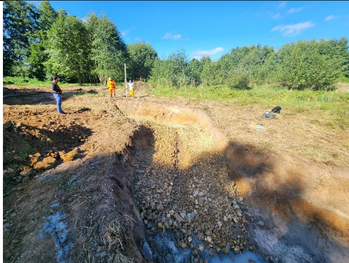
Bras méandriforme - Terrassement
