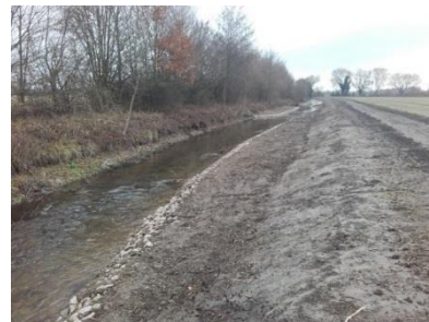
Retalutage et rétrécissement de la section d'écoulement
