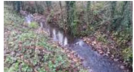
Réalisation de banquettes et de radiers
