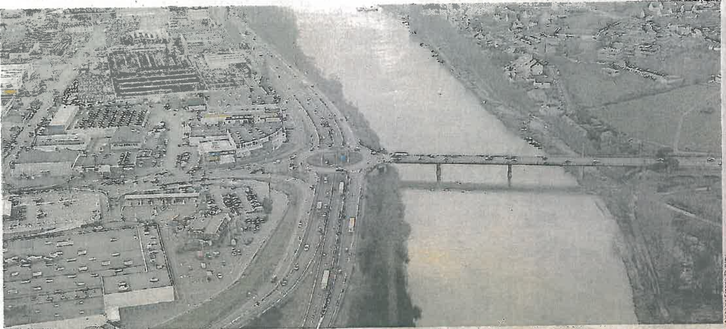
Dans la région, 7 319 PME, artisans et commerçants sont menacés d'inondations lors de crues importantes de la Loire ou de ses affluents, ici la Maine.
