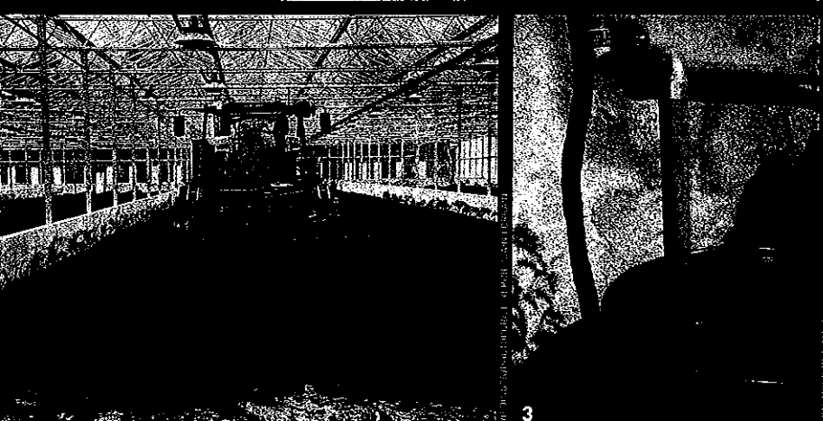
(1) Bassins de décantation de la station d'épuration de Valenton (Val-de-Marne). (2) Celle de Forbach-Mariénau (Moselle) est équipée d'une serre pour le séchage solaire des boues. (3) De simples cuves de récupération de l'eau de pluie diminuent la facture d'eau des particuliers.
