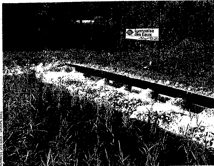
D'un aspect visuel intéressant, la lagune nécessite peu d'entretien, ainsi qu'une maintenance et une consommation d'énergie réduites.
