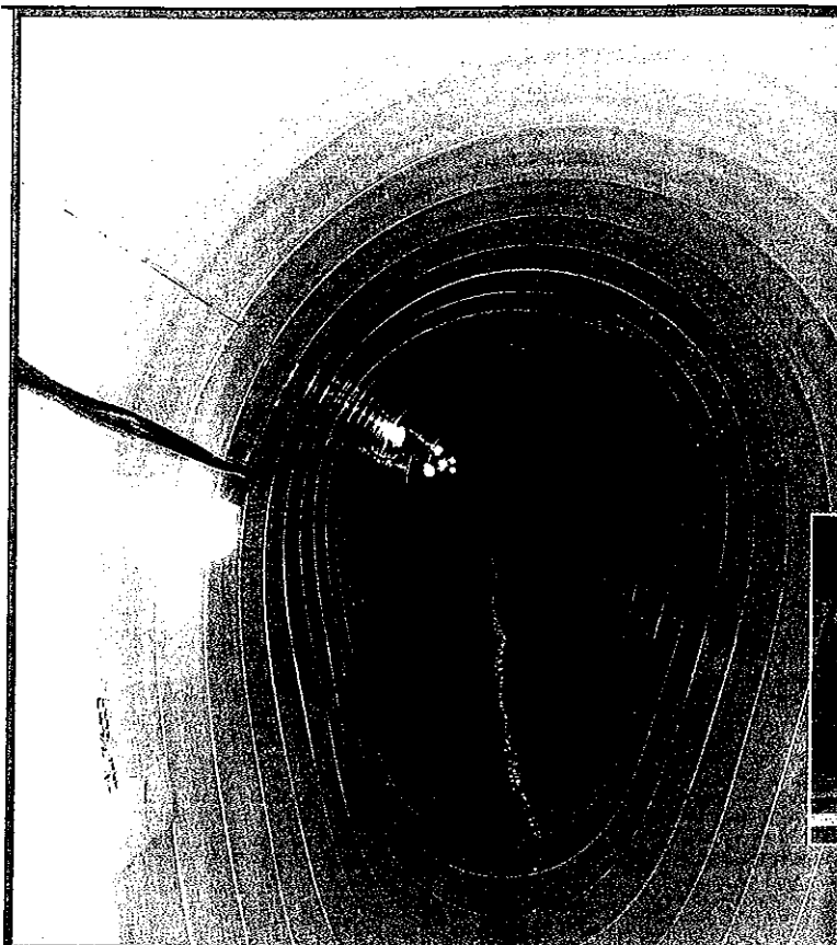
Grâce au tubage par enroulement hélicoïdal, le collecteur retrouve ses capacités hydrauliques.
