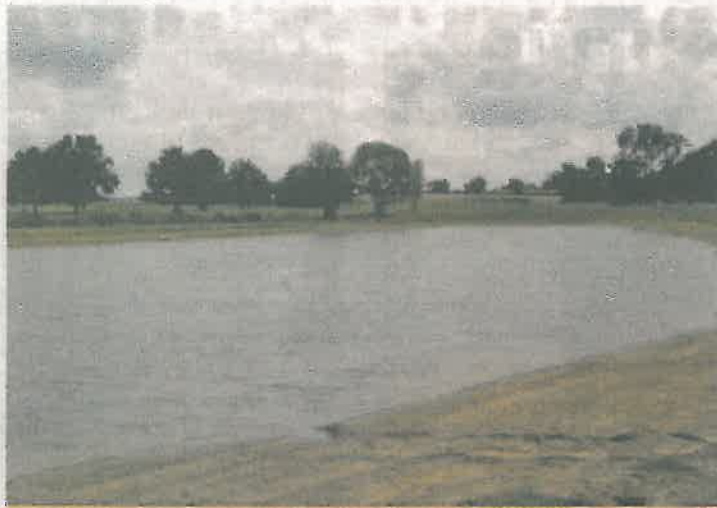
Des réunions d'information sur la constitution de réserves d'eau sont proposées aux agriculteurs. La première sera le mardi 22 novembre à Doué-la-Fontaine.
